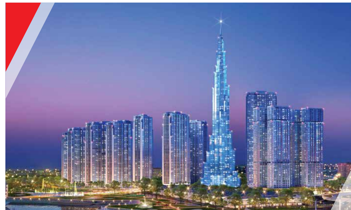
VINHOMES CENTRAL PARK - THÁP CENTRAL 1 VÀ THÁP PARK 5 KHU TÂN CẢNG - 720A ĐIỆN BIÊN PHỦ - PHƯỜNG 22 - Q. BÌNH THẠNH - TP. HỒ CHÍ MINH
